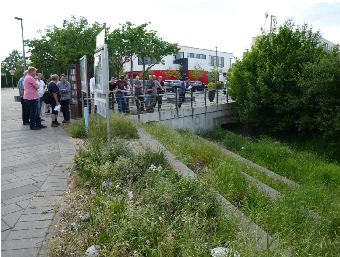
Abbildung 12: Treppenstufen am Hartmut-Nimmerrichter-Platz (eigene Aufnahme)
